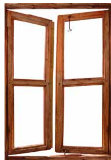
Een raamkozijn vergt regelmatig onderhoud.
